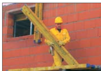
Auch im Winter wird gebaut.
