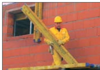
Auch im Winter wird gebaut.
